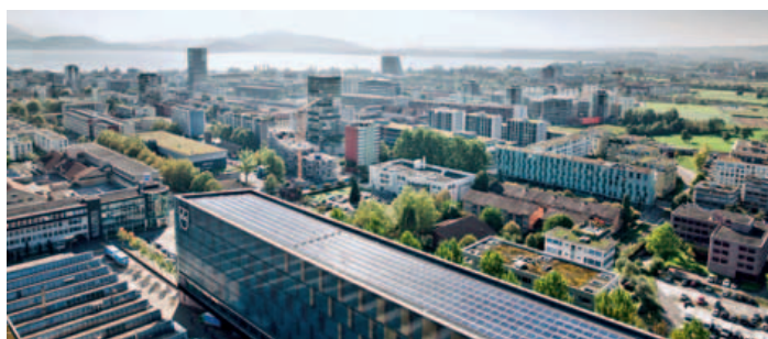
Sede e stabilimento di V-Zug a Zug in Svizzera
